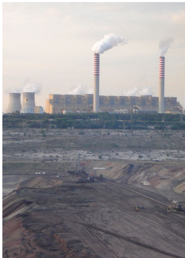
Rys. 9. Kopalnia odkrywkowa węgla brunatnego i elektrownia Bełchatów
